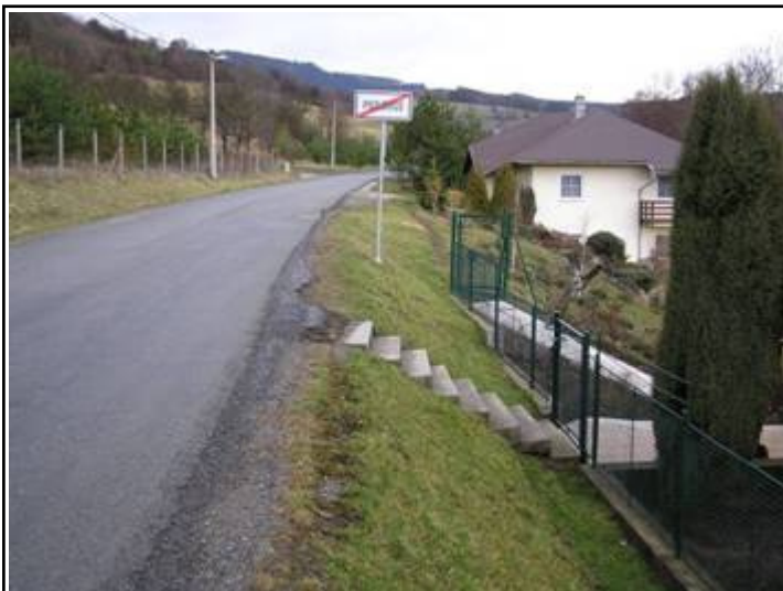
Konec úpravy – chodník v násypu, nutná opěrná zídka
