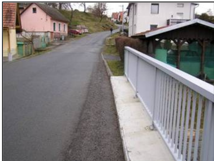
Začátek úpravy – návaznost na spravený most ev.č. 4922-2
