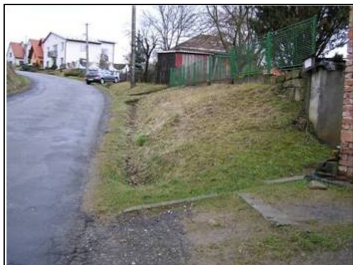
úsek km 2.745 – 2.778, budoucí chodník v zářezu, nutná zídka
